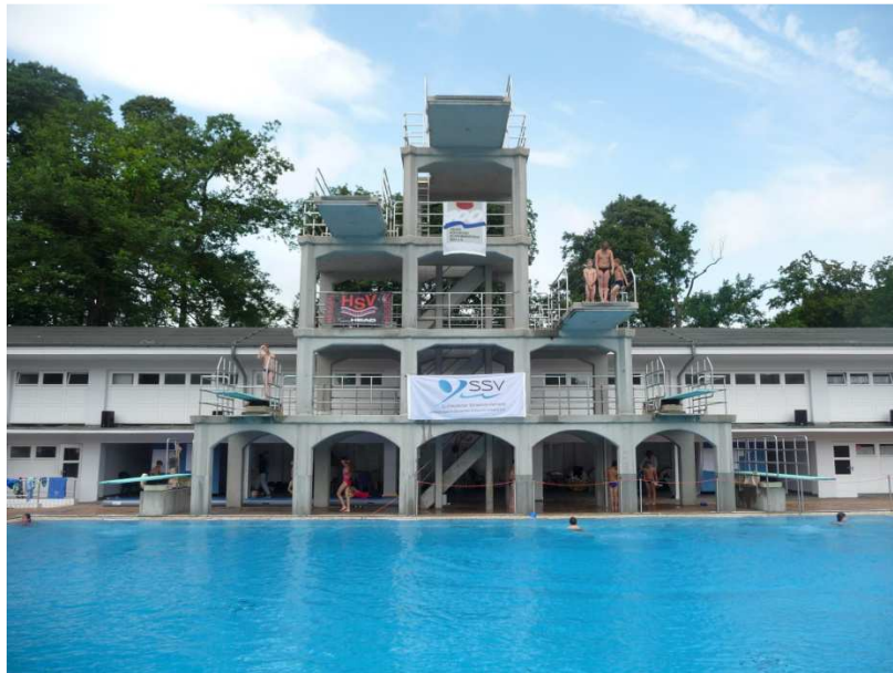
Die tolle Sprunganlage im Stadionbad
